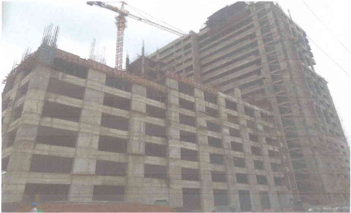
PHOTO.1 Construction site on 27.03.2017
