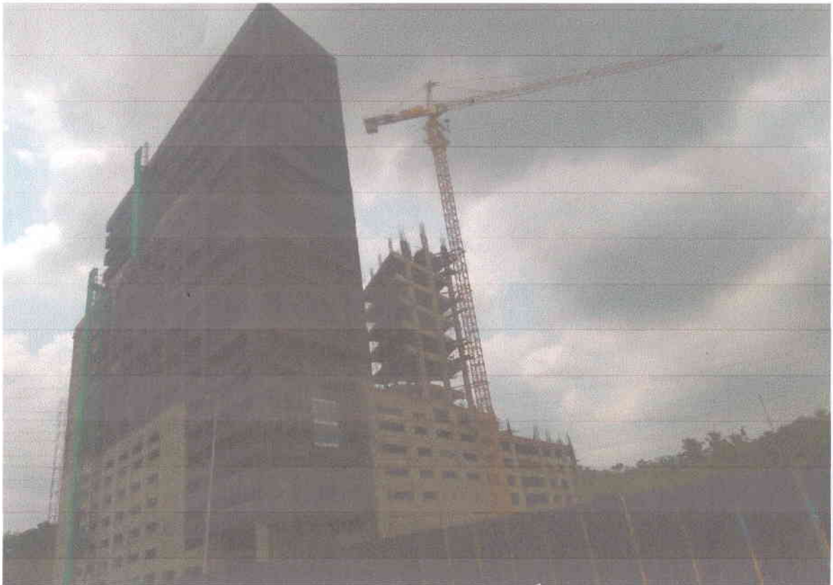
PHOTO.1 Construction site on 27.03.2017
